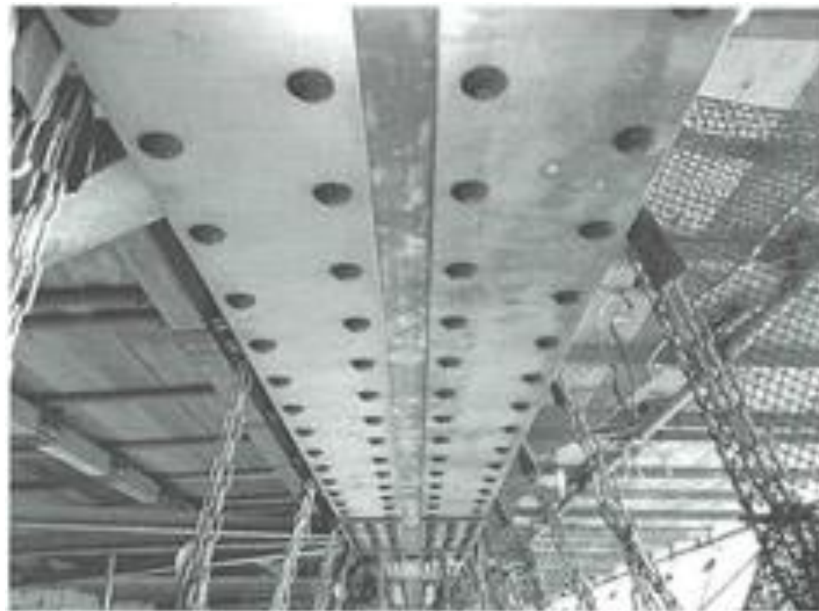
写真-3 下フランジ当て板補強
