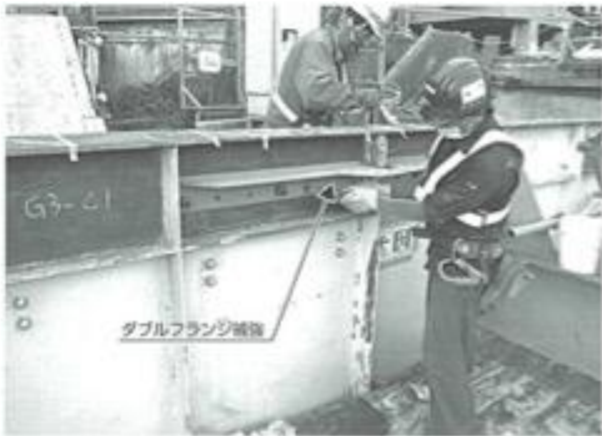
写真-2 ダブルフランジ補強
