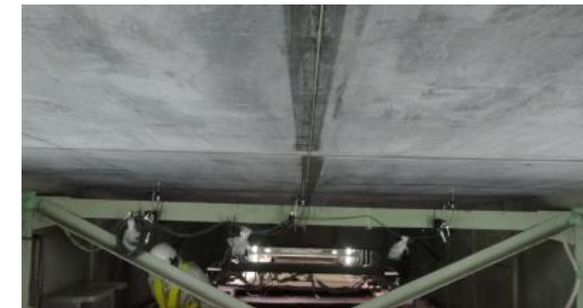
写真 変位計(床版下面)
